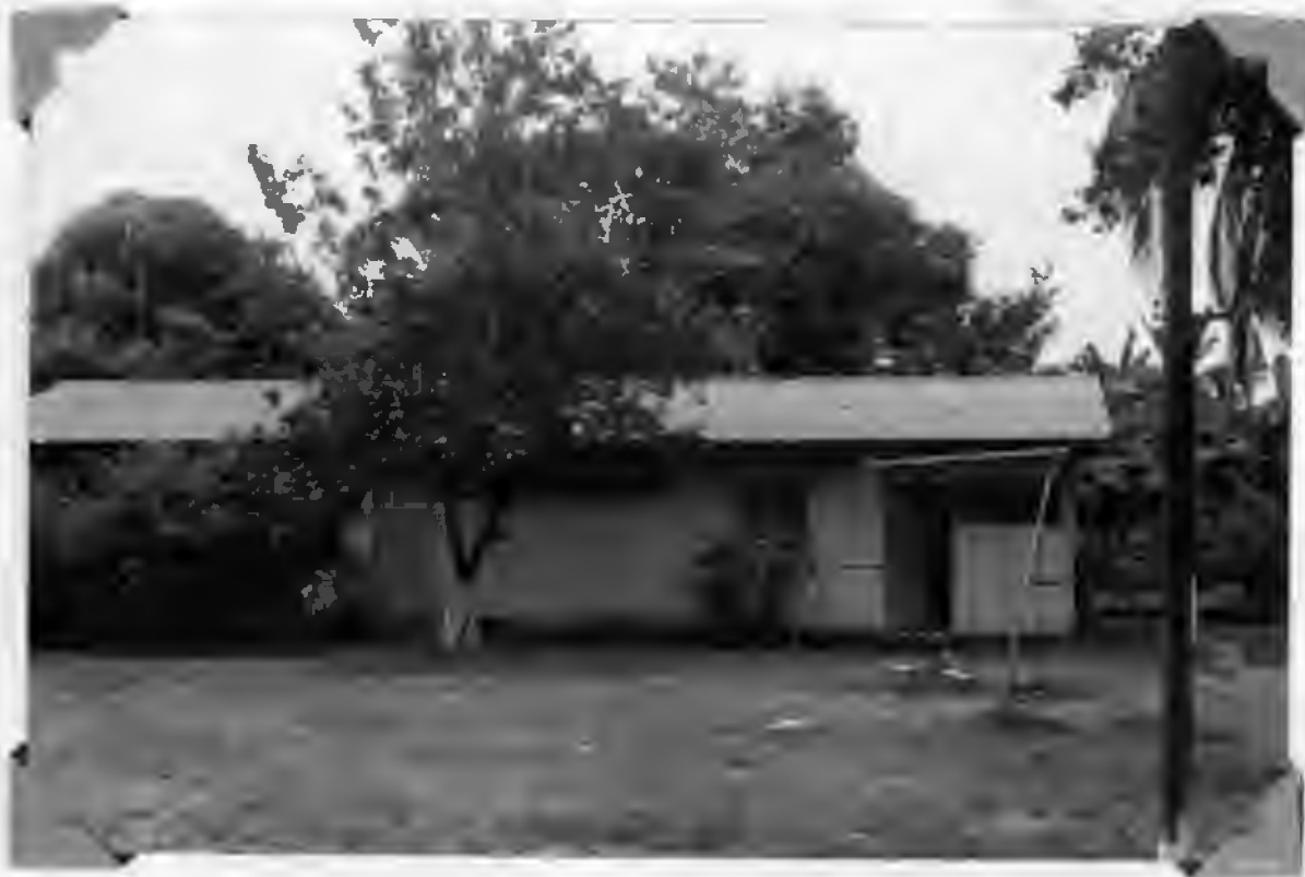
Foto No. 10. Vivienda para los trabajadores con familia en los predios de la empresa.
