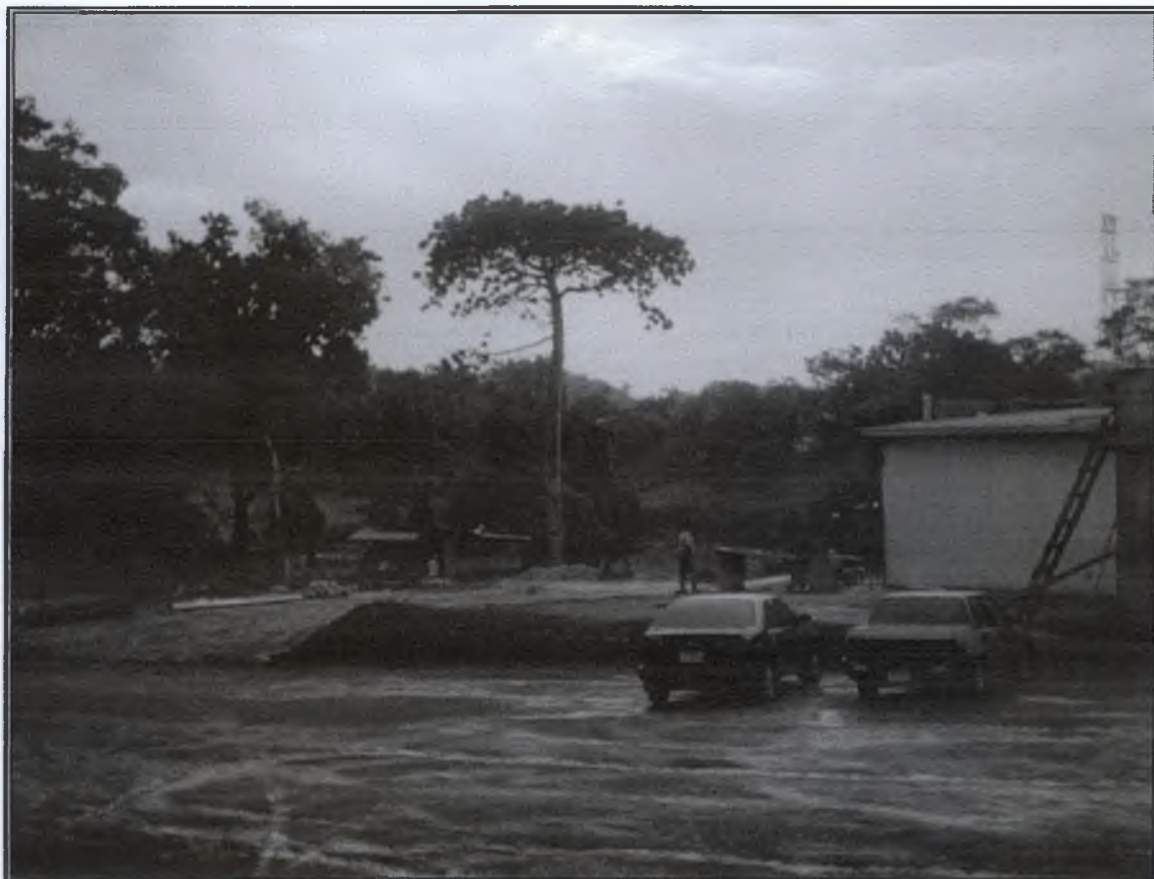
Figura 3. Vista Actual del Sitio del Proyecto
