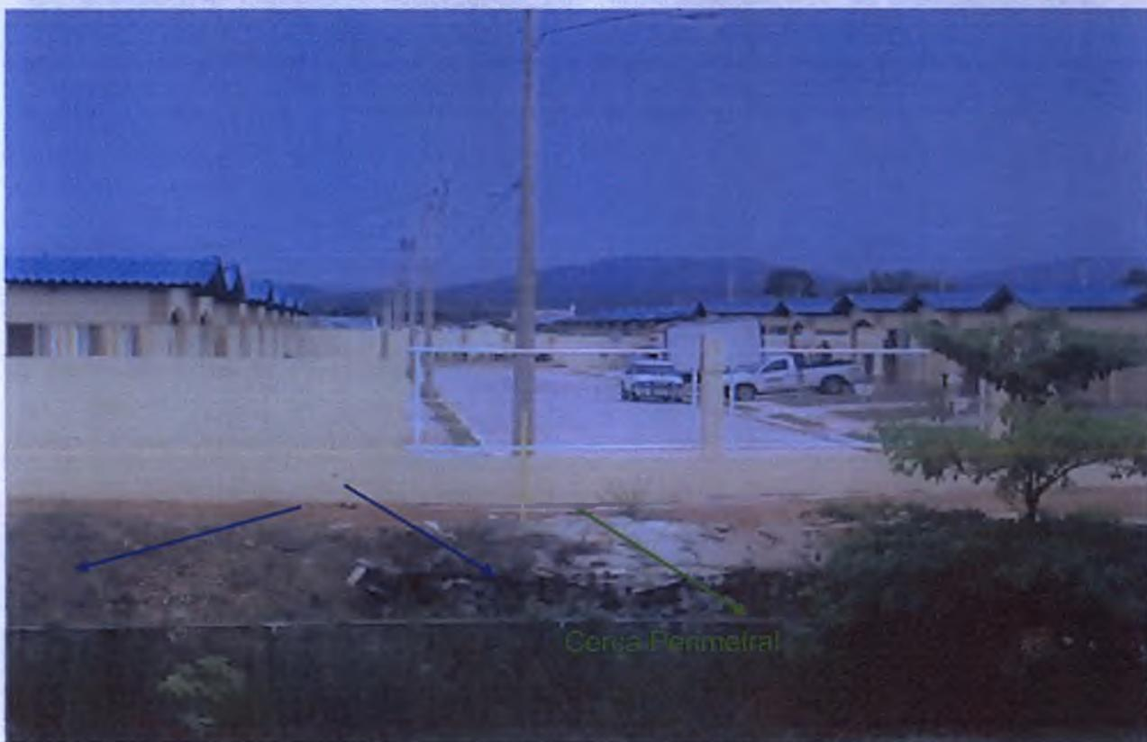
**Observación:** El relleno esta por encima de la cerca perimetral de la propiedad, de esta manera se asegura la altura mínima sobre el nivel máximo de la marea más alta con la situación de lluvia torrencial. Una situación similar se dará en el caso del relleno para el proyecto "Adecuación y Conformación de Terreno"
