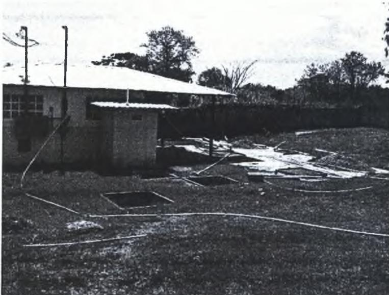
**Foto N°5: En la imagen se aprecia la Planta de tratamiento de aguas residuales de la Barriada La Siesta, la cual drena sus aguas a una canal. De acuerdo a los moradores, esta Planta no funciona y los perjuicios de ello, se refleja en malos olores e inundaciones.**
