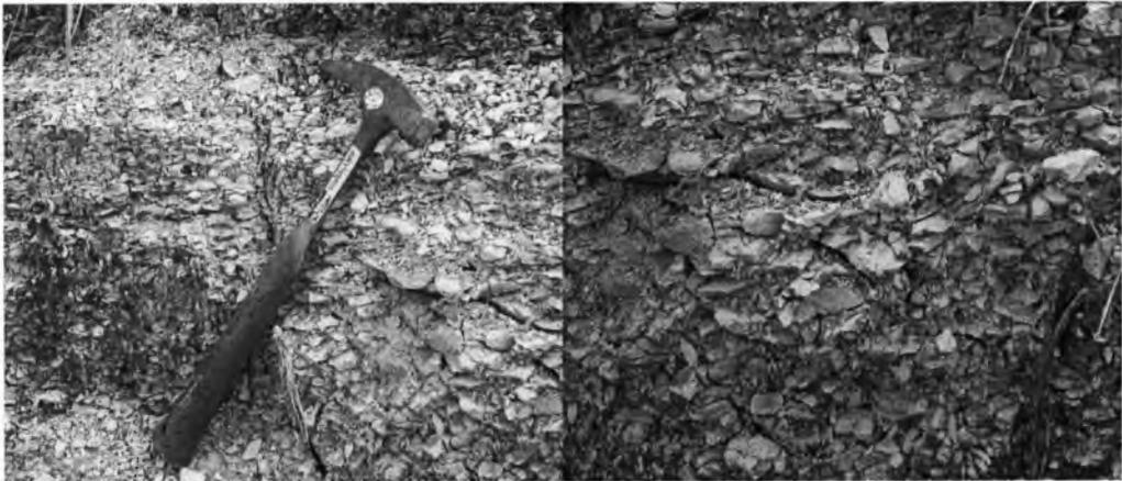
Fotos N° 6, 7 La roca sedimentaria se ve afectada por diaclasas y fisuras en casi todas las direcciones
