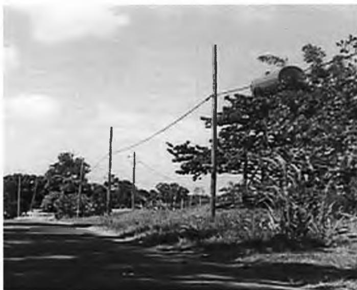
Foto N° 19 Vista del Taque de Reserva de Agua Potable, con capacidad para 15,000 galones, instalado en la comunidad de El Naranjal.
