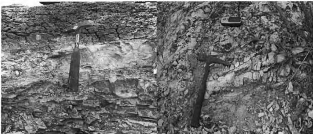
Fotos N° 4, 5 La roca sedimentaria se ve afectada por diaclasas y fisuras en casi todas las direcciones
