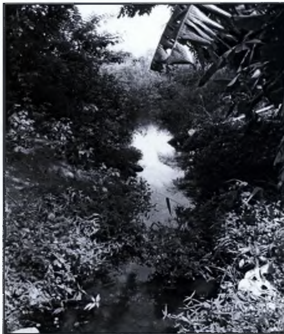
Foto N° 2: Canal pluvial al extremo Este del proyecto
