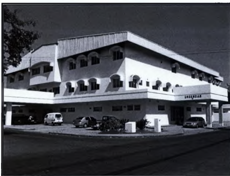
Foto N° 16: Vista del edificio nuevo del Centro de Salud de Juan Díaz
