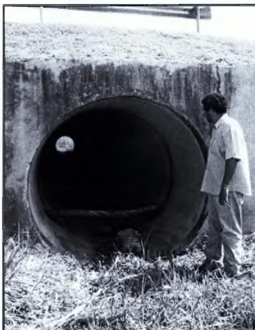
**Foto N°22: Tubo de drenaje pluvial de Ø 2.10m por debajo del Corredor Sur a la altura del proyecto VERSALLES II**
