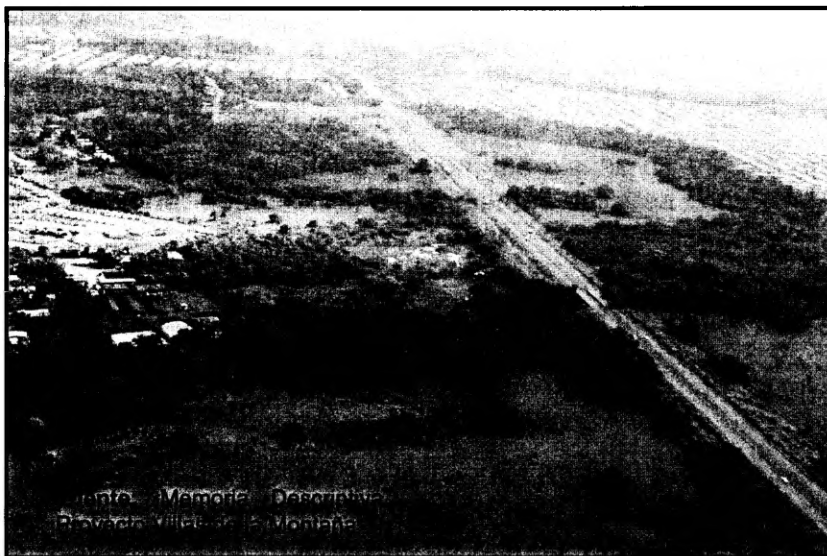
Foto Vista del Autopista Arraiján – La Chorrera.
