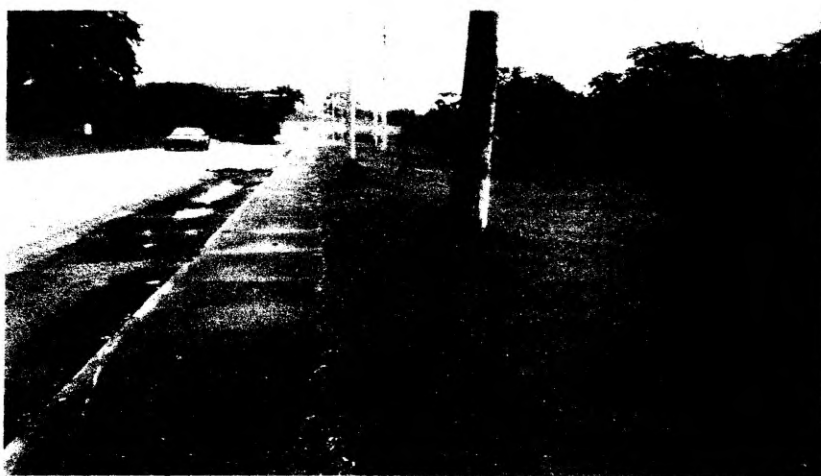
Vía que será afectada por el movimiento de vehículos pesados durante la construcción
