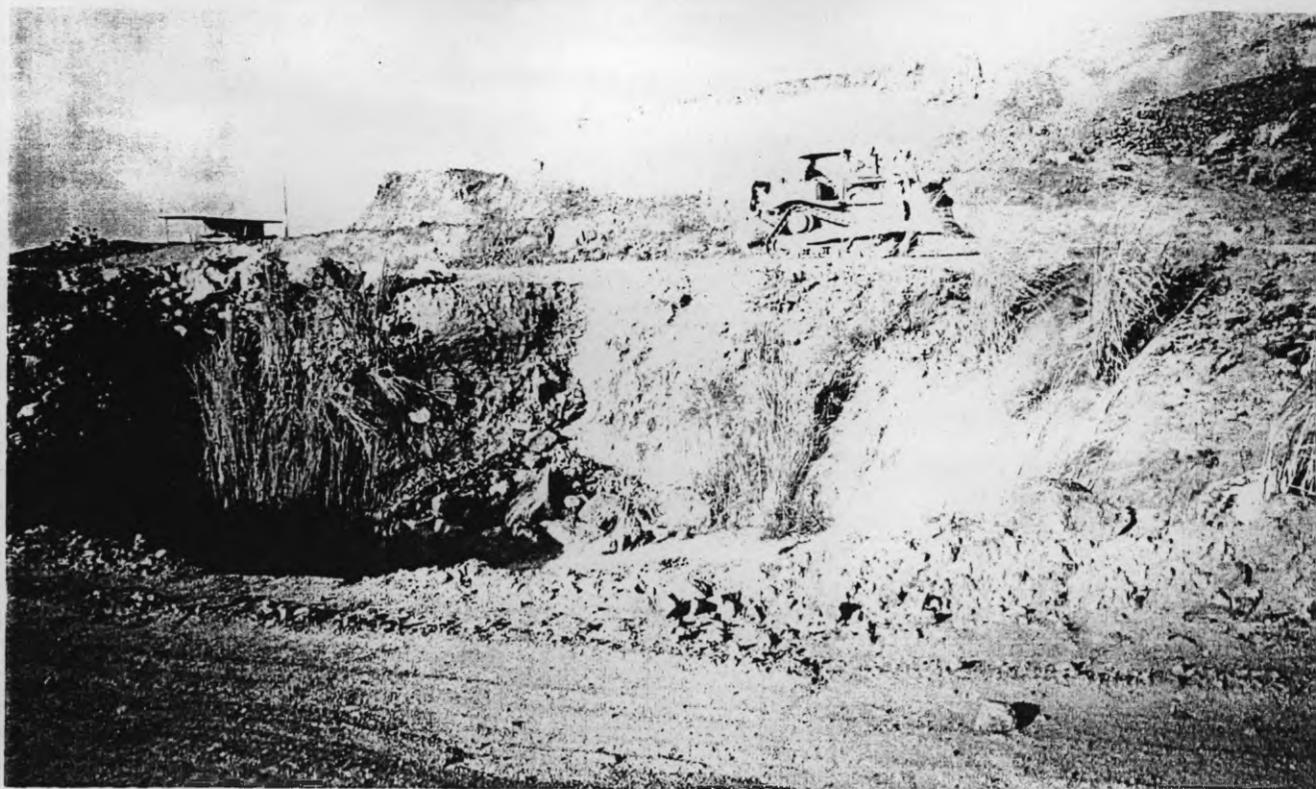
**Arriba en la foto No. 13 vista de la aplicación de una medida de mitigación preventiva del control de la erosión (tinas de sedimentación).**
