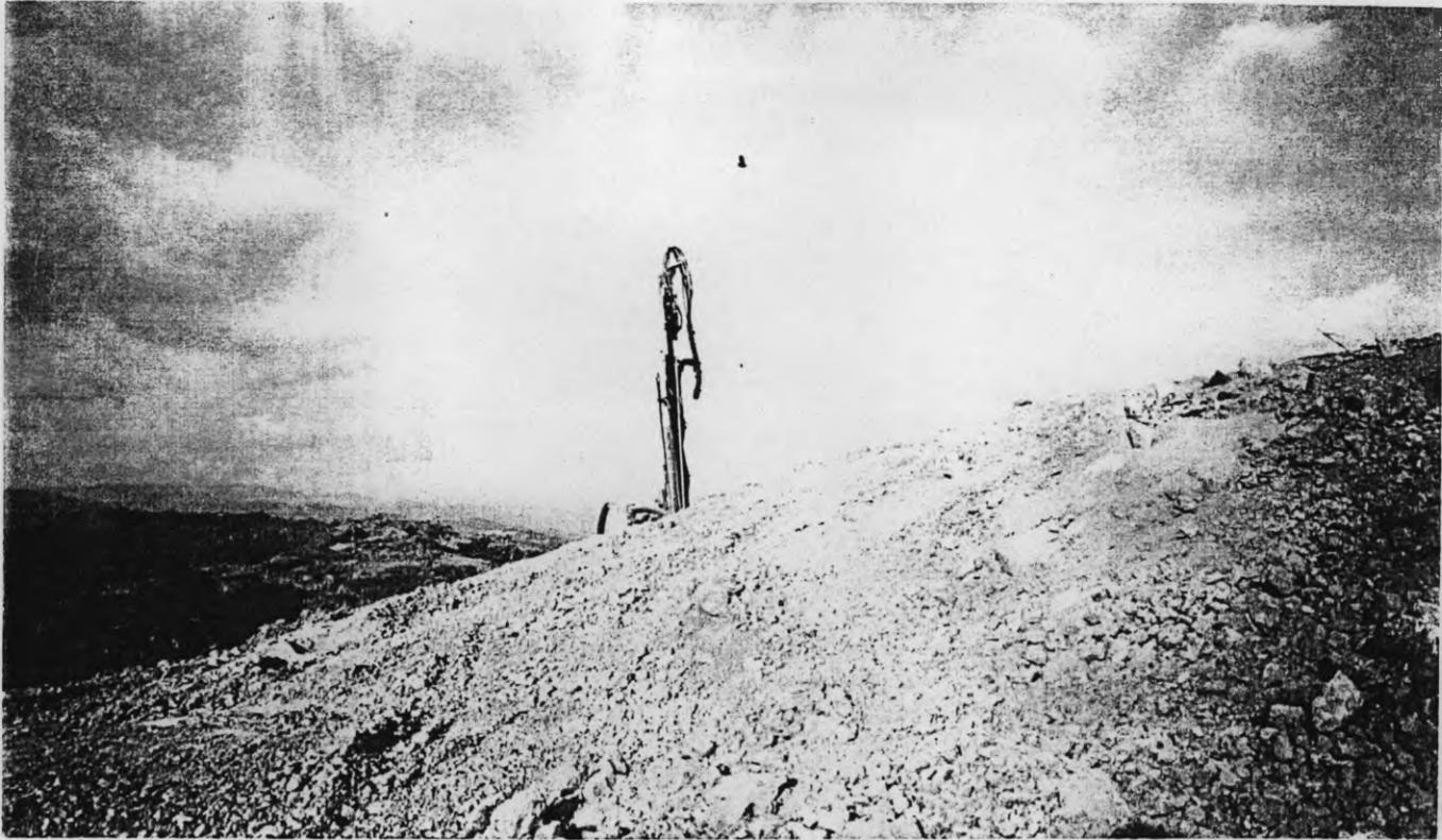
Arriba en la foto No. 15 vista de la perforadora utilizada para abrir los hoyos que serán utilizados para colocar los explosivos (cada hoyo es un tiro)
