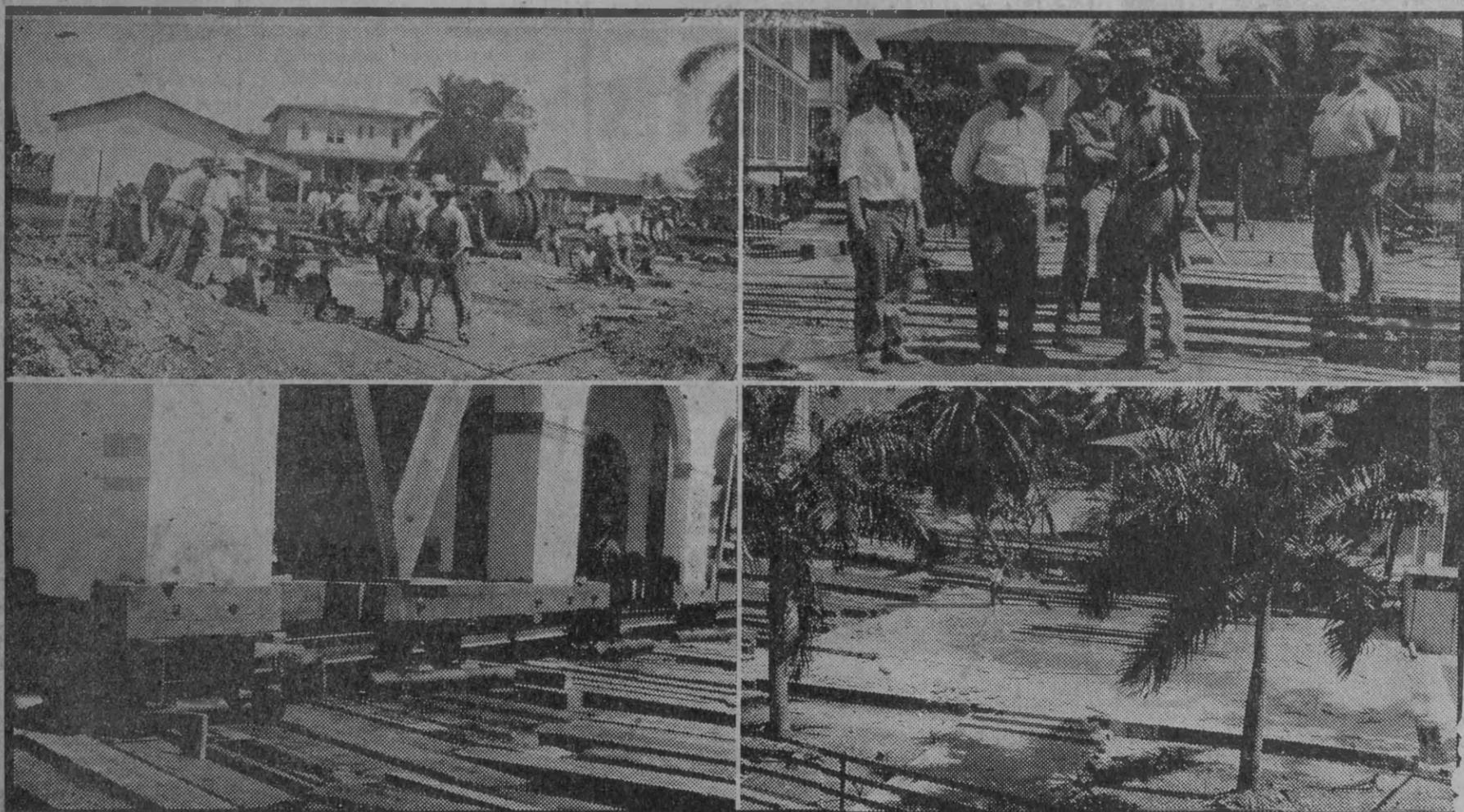
De izquierda a derecha Ed. Sperman, A. A. Lombroia, G. Farley y E. L. Smith encargados de la dirección de los trabajos de traslado.—Uno de los torniquetes con que se hala la casa a su nuevo sitio.—La base de donde se quitó el edificio.—Detalle de los refuerzos puestos en la base del edificio y trabajo principal del traslado. (Vease pag. 9)
