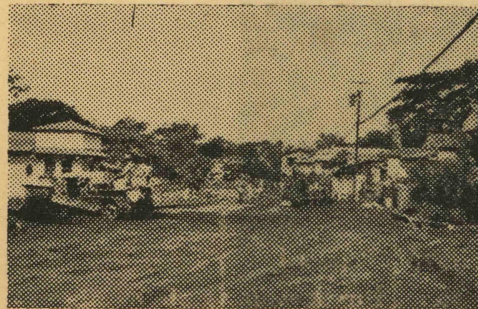
Reconstrucción de concreto de la Vía Porras hace aproximadamente 21 años. (Foto Flatau)
