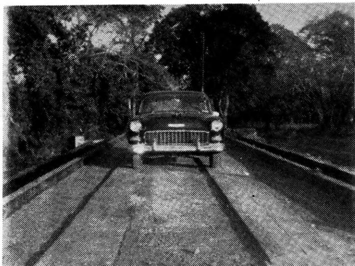
Puente sobre el Río Purio, camino de Pocrí de Las Tablas a Pedasí. Se puede apreciar en la fotografía - el piso de madera completamente nuevo con su cubierta de piedra "Lenteja" y - RC-2. El trabajo demoró - solamente 10 días.
