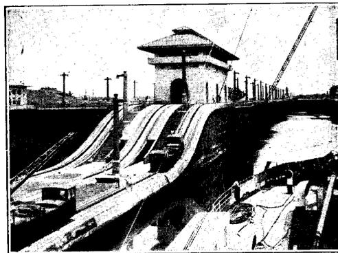
Locomotoras tirando un vapor en las esclusas de Gatún.
