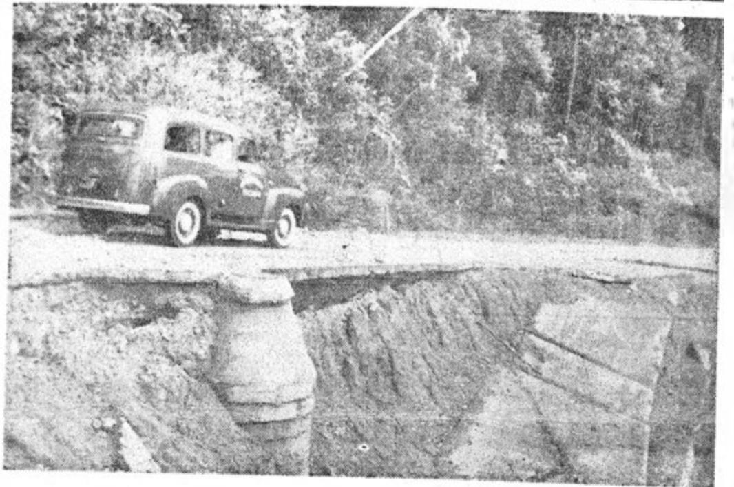
Un verdadero peligro constituye un tramo de la carretera que va hasta Cerro Azul, en vista de que por efecto, quizá de la mala construcción o de las lluvias, se derrumbaron las bases de la misma, quebrando totalmente la carretera, la cual ha quedado en esa sección convertida en una sola vía pues la otra se fue al precipicio.— Las fotos muestran la forma cómo ha quedado la carretera y el peligro de un accidente.
