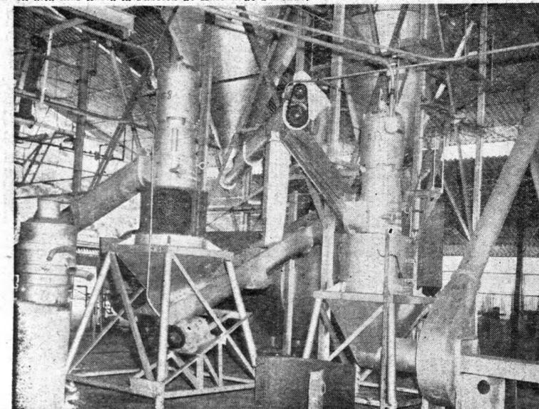
Desde la prensa, una vez extraídos los líquidos, se pasa el pescado hasta molino húmedo y de allí se conduce al cilindro y es secado por aire caliente.
