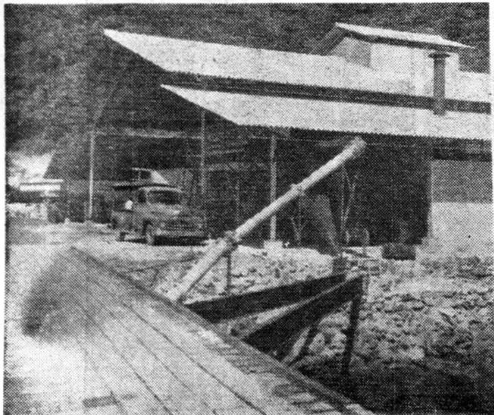
Podemos apreciar aquí un tubo de diez pulgadas de diametro por donde se envia el pescado desde el muelle flotante a la planta por medio de una bomba centrífuga.
