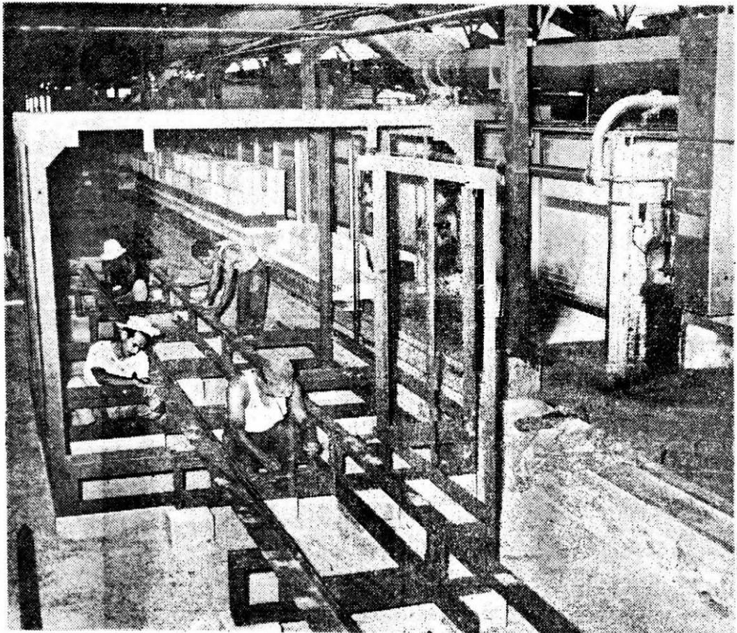
Un nuevo horno tipo continuo, dotado de los últimos adelantos en la materia, para producir azulejos, cerámica y baldosas de piso, está montando la Cía. de Productos de Arcilla, S. A., con el propósito de aumentar apreciablement la producción de los diversos productos que fabrica.
