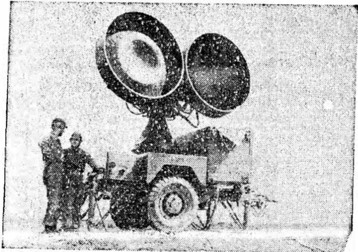
**EL RADAR HAWK.**— El radar usado en el sistema de defensa Hawk del Ejército de E.U. da al proyectil su notable capacidad para localizar y destruir atacantes que vuelen a baja altura, aun por encima apenas de los árboles. El radar localiza automáticamente el objetivo, dejando a un lado los reflejos que no son necesarios, o sean los de los objetos estacionarios del terreno.
