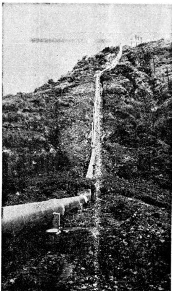
Tubería de presión vista desde abajo. En lo alto se puede apreciar la chimenea de equilibrio.
