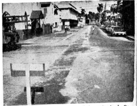
La importante obra del alcantarillado sanitario de Colón avanza notablemente, tal como se puede apreciar en una de las avenidas, ya selladas por la Constructora Urbana, una vez colocada la tubería.
